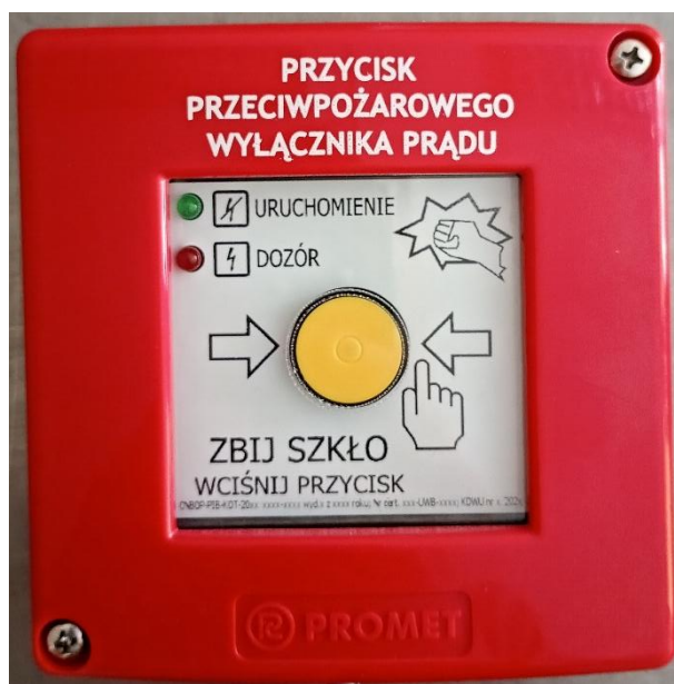
Ryc. 2. Widok wewnętrzny przycisku przeciwpożarowego wyłącznika prądu typu PPWP-B Źródło: CNBOP-PIB.
