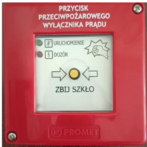
Ryc. 1. Widok zewnętrzny przycisku przeciwpożarowego wyłącznika prądu typu PPWP-A Źródło: CNBOP-PIB.
